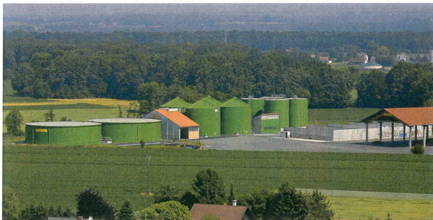
Die 1000 kW Biogasanlage Mureck wurde von der Fa. Rohn aus 91610 Insingen (tel 09869/616) geplant.
