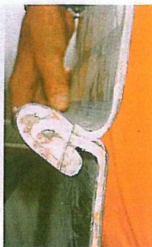
Der Aufbau der Edelstahl-Fermenter im Sommer 2004. Hier sind schon vier Bahnen gefalzt und das Dachgerüst aufgesetzt. Das kleine Bild zeigt den Falz im Detail.
